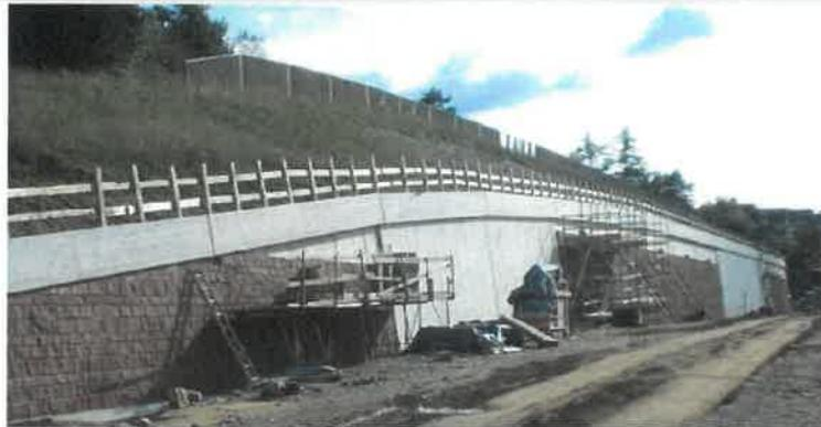
Bauphase: oben Bohrpfähle und Pfahlkopf, unten Verblendmauerwerk
